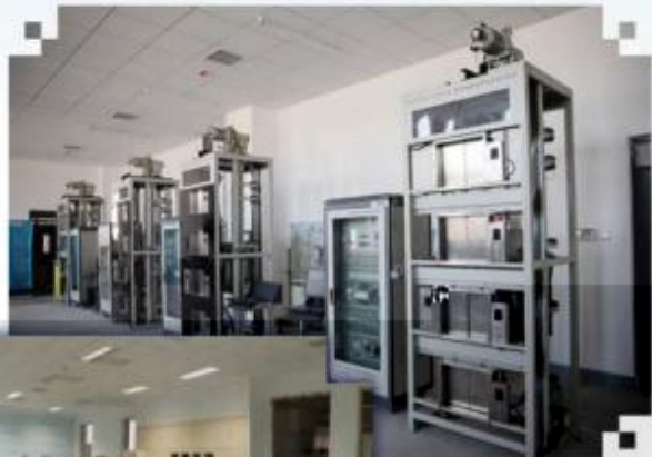
智能电梯安装调试 维护训练场所
